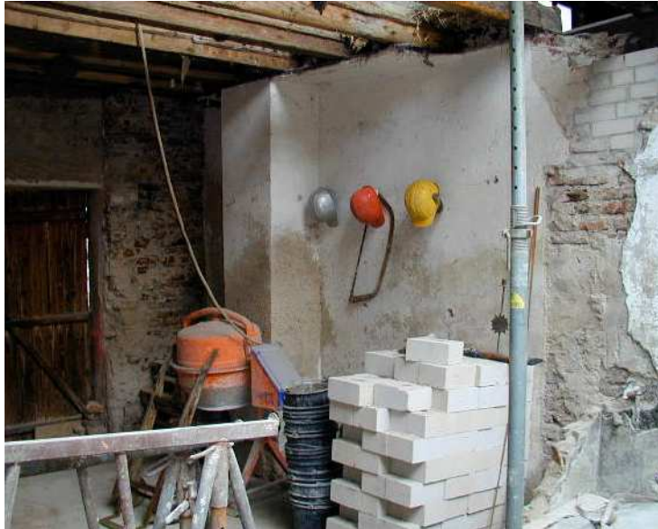
GARAGENDURCHFART VOR DURCHBRUCH DER NEUEN ÖFFNUNG.
