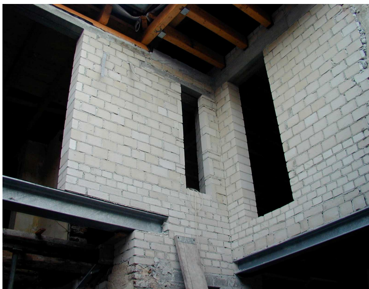
DIE HOFFASSADE WURDE GEÖFFNET, DECKENHOHE FENSTERTÜREN SIND GEPLANT.
