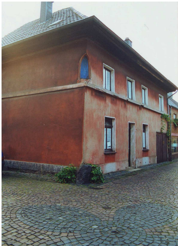
GRÜNWALDSTRASSE/ECKE TURMSTRASSE IM BESTAND IM JAHR 2001
