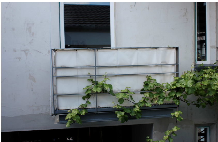
HOFANSICHT FASSADE NORDWEST 2006
