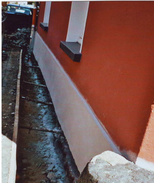
GRÜNWALDSTRASSE SANIERTER SOCKELBEREICH VOR VERFÜLLUNG DES GRABENS
