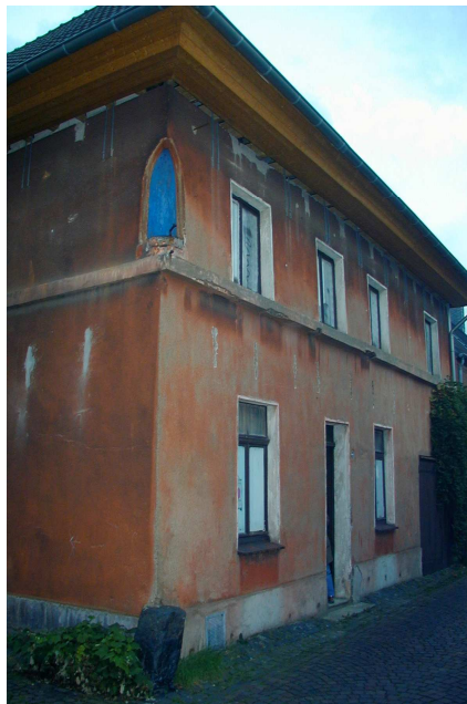
2003 NACH FASSADEN- VERANKERUNG MIT INNENLIEGENDEM STAHLRAHMEN
